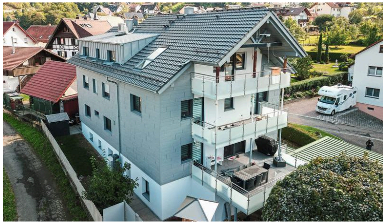
Hier ein Blick auf die erfolgreiche Sanierung eines Wohnhauses in Bühlertal mit einer PREFA Siding-Fassade. Foto: Klöpfer GmbH & Co. KG
