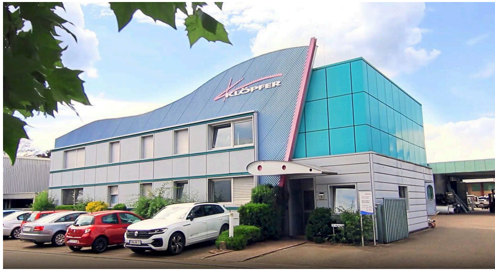
Das Betriebsgebäude der Gerhard Klöpfer GmbH & Co. KG (Aufnahme von 2024) verfügt auch über eine moderne Werkstatt mit allen notwendigen Maschinen und Geräten. Foto: Klöpfer GmbH & Co. KG
