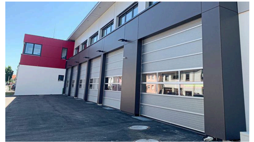
Zu dem Portfolio gehört auch die Ausführung der vorgehängten hinterlüfteten Fassade des Feuerwehrgerechtes in Kuppenheim. Foto: Klöpfer GmbH & Co. KG
